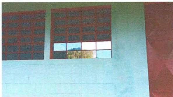
Foto1: Fachada de escuela Remozado
