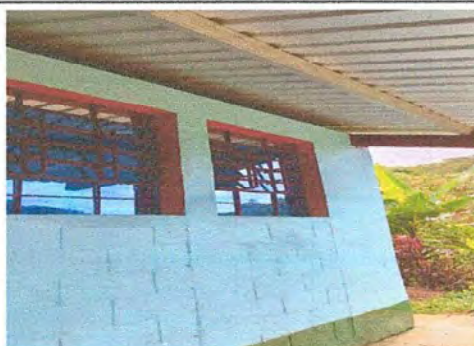
Foto 3: Durante la contruccion cambiamos las costaneras el establecimiento
